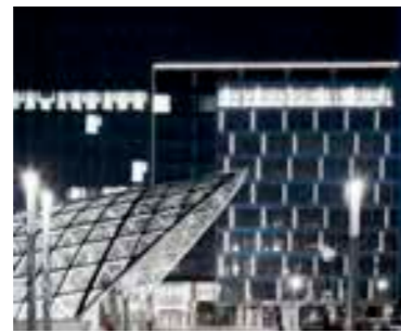
Dworzec Zachodni Warszawa, Ochota
