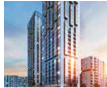
Towarowa Towers Warszawa, Wola
